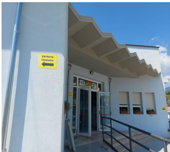
foto 2: ingresso primaria lato sinistro rispetto al portone principale
